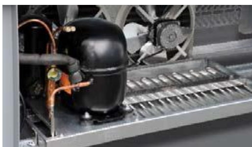
Samodejno izparevanje kondenzata (modeli z vgrajenim agregatom)
